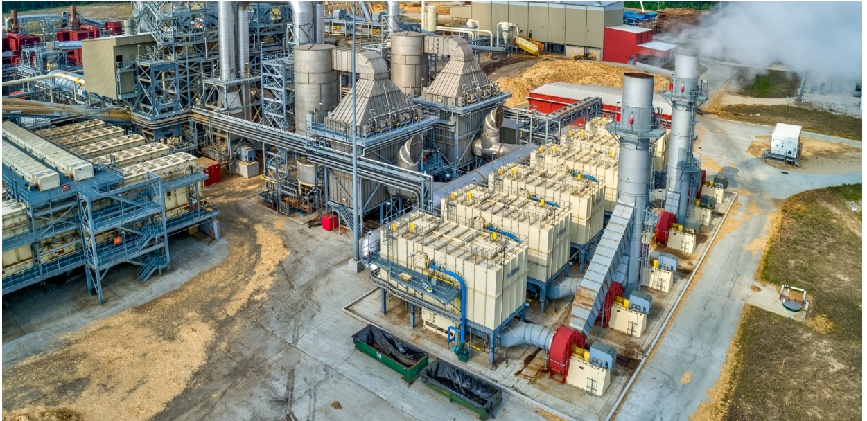
Abb. 4: Kombination von Dürr Part.X und Oxi.X in der Holzwerkstoffindustrie
