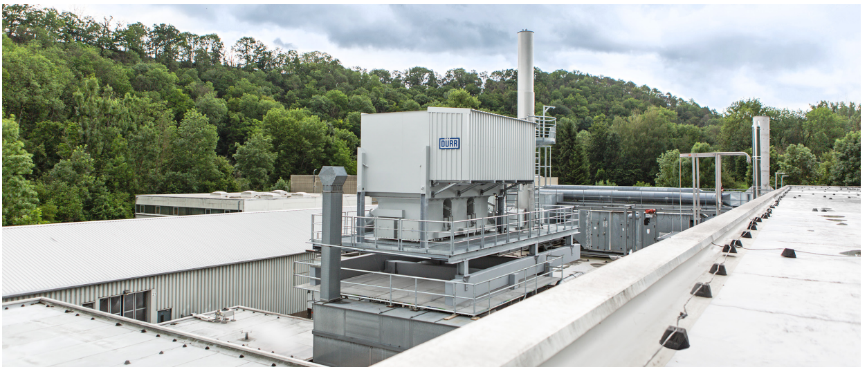
Abb. 2: Kompakte und vorinstallierte Oxi.X RK RTO
